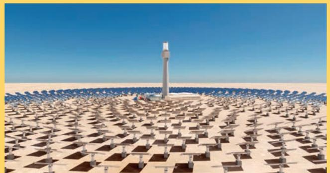
*Campo de heliostatos (espejos) que reflejan los rayos solares y los dirigen a una torre central donde se concentran en el llamado absorbedor solar (parte alta de la torre) que se calienta y transmite el calor hacia el aire que se hay en el interior de la torre; ese aire que se ha calentado acciona una turbina desde la que se obtiene energía; este es el fundamento de la energía solar por concentración (CSP)*
