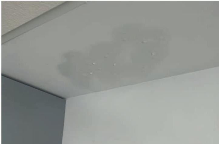
Detalle del problema de goteras en el sótano
