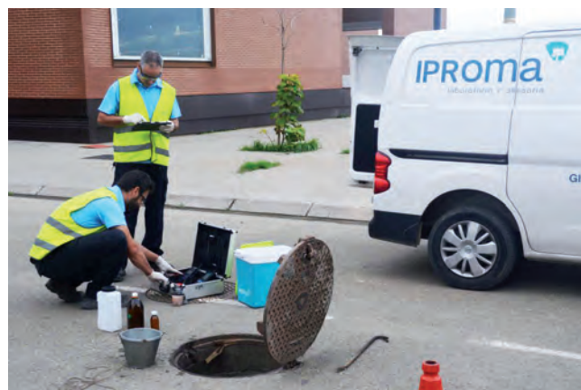
Los análisis in situ también incluyen la toma de muestras en canalizaciones de aguas residuales.
