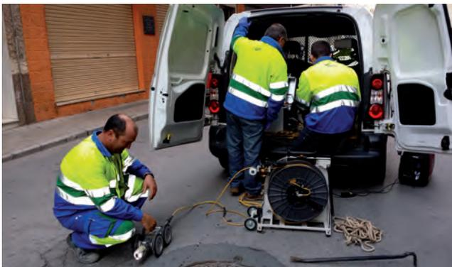
infiltración de raíces, elementos sobresalientes (acometidas, tomas de tierra...), localización de objetos que obstaculicen el paso del caudal y provoquen atascos continuos, vertidos incontrolados y cualquier otro problema que provoquen atascos o filtraciones.
